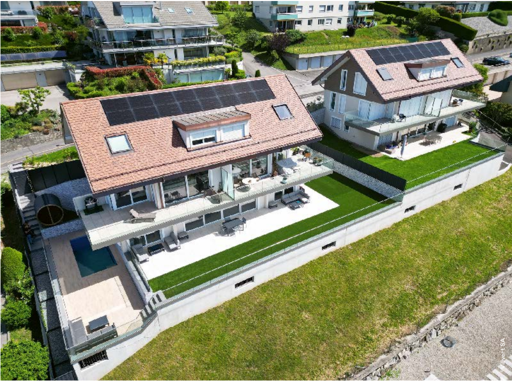
Les Perles du Lac à Corseaux. Deux PPE comprenant chacune trois logements de standing avec une vue magnifique sur le lac Léman et les Alpes.
